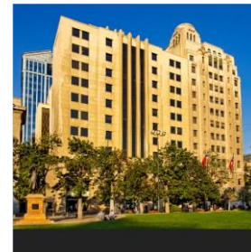
Banco Central de Chile, órganos estatales Superficie Util: 17.225 m²
