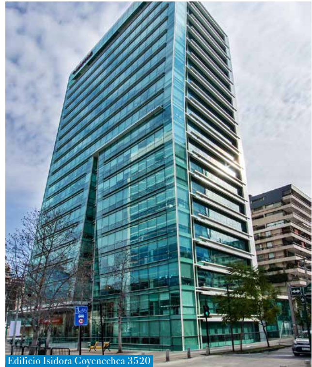
Edificio Isidora Goyenechea 3520
