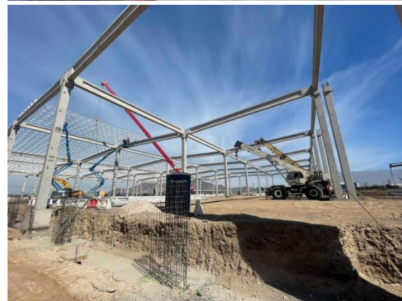
Última Etapa del Proyecto ENEA de 22.000m 2 en construcción
