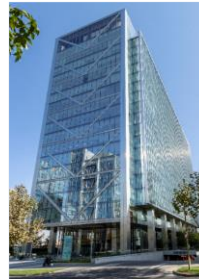
Edificio Cerro el Plomo 6000
